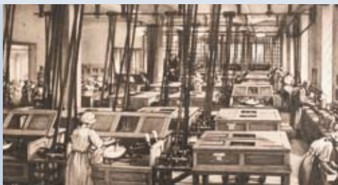
Trituration machines of the Willmar Schwabe Company, Leipzig, c. 1926 © 60 Jahre im Dienst der Homöopathie 1866–1926
